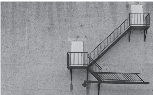
Fluchttreppe Carnegie Hall (Bild oben), bewegliche Feuertreppe (Bild unten)
